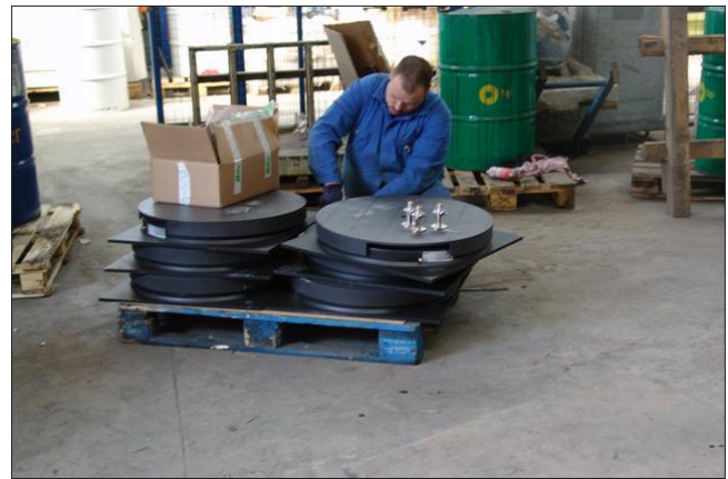
VOORBEREIDING VAN DE ISOLATOREN.
