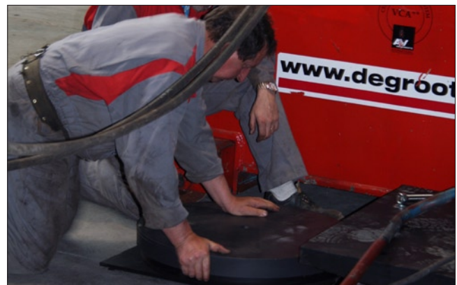
POSITIONEREN VAN DE ISOLATOREN ONDER DE STRUCTUUR.
