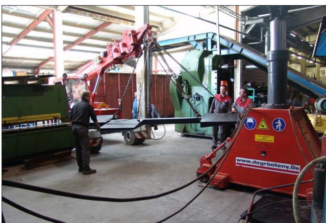
AANBRENGEN VAN DE STALEN STRUCTUUR.
